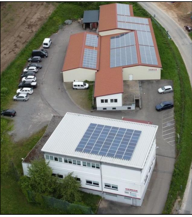
Heute. Die Siebeck GmbH neben der Friedrichsdorfer Landstraße. Rechtes Bild: eine Verschnürmaschine.
